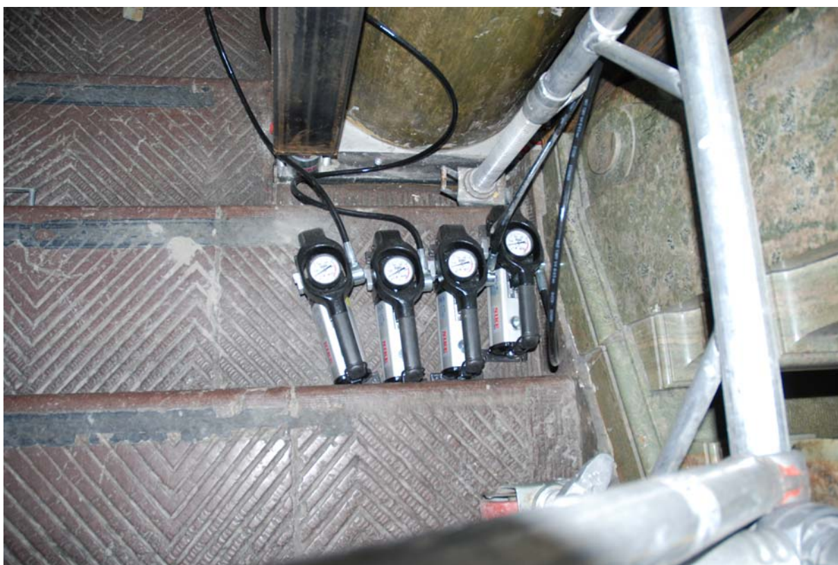
Alla fyra stämpan förspända till 62,5 kN (200 bar pumptryck).
