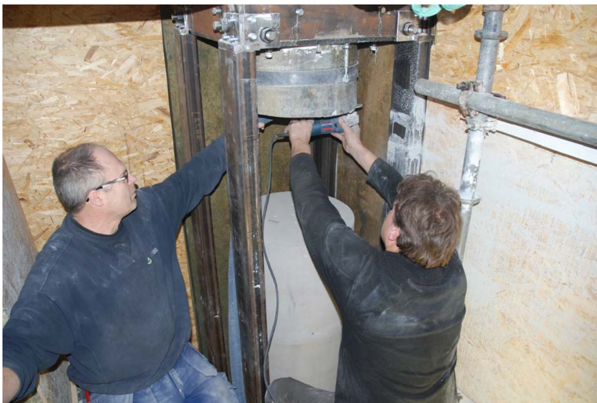
Finjustering av övre fog före montering av övre trumma.
