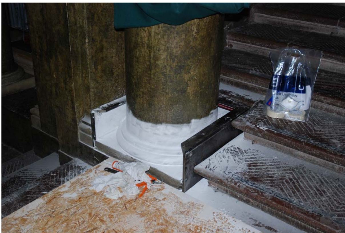
Montering av stålkrage. Det vita är Cyclododecan som användes som släppmedel.
