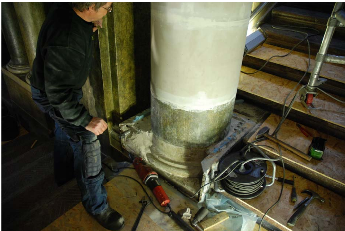
Rivning av nedre krage på kolonn 3. Den vita Cyclododecanen fanns kvar bakom betongen.
