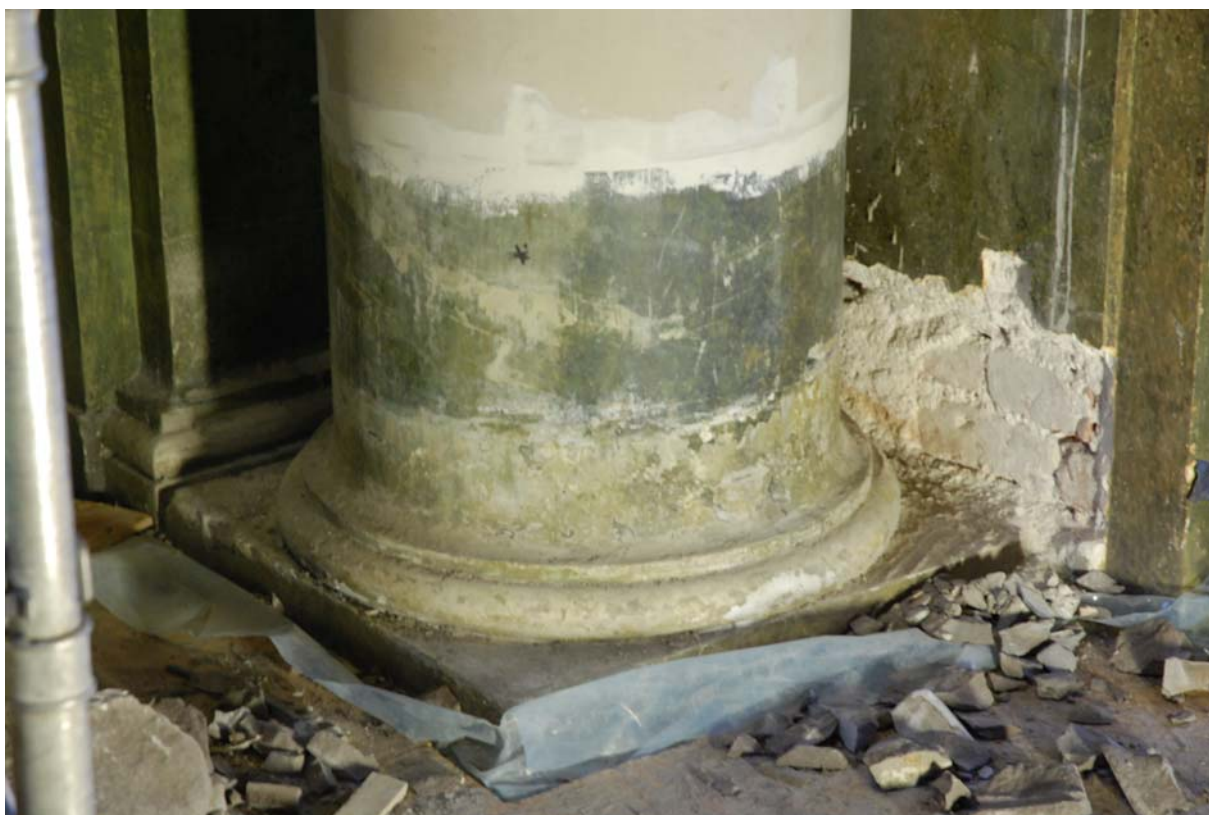
Kolonnbasen frilagd på kolonn 1.
