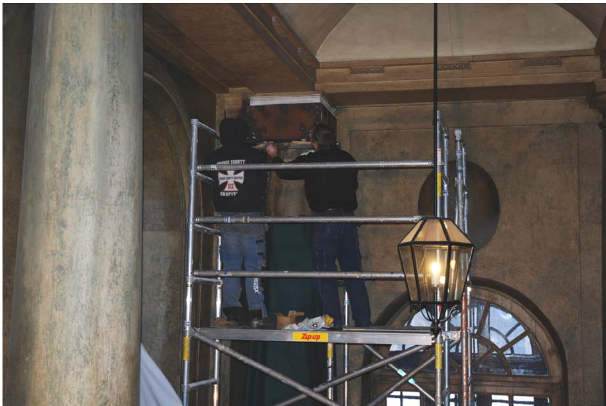
Montering av övre stålkrage.
