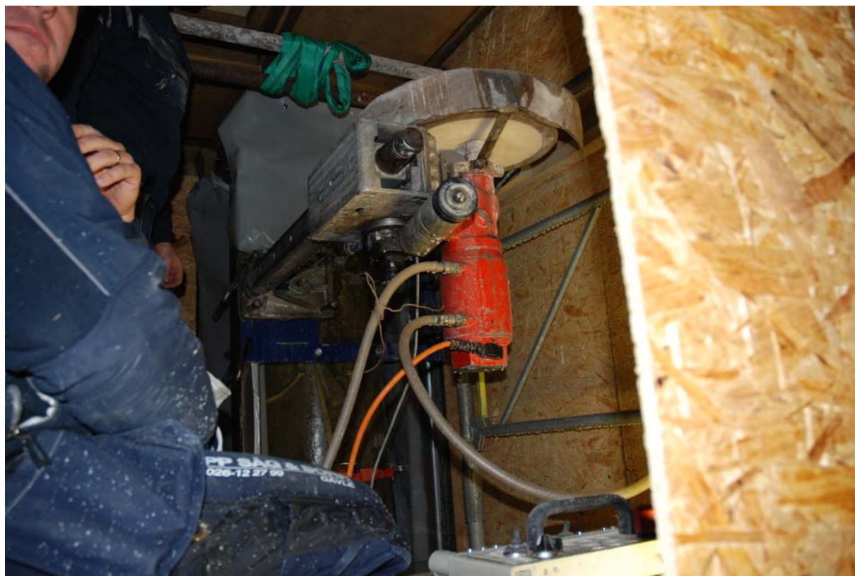
Sågning av övre snitt på kolonn 1.
