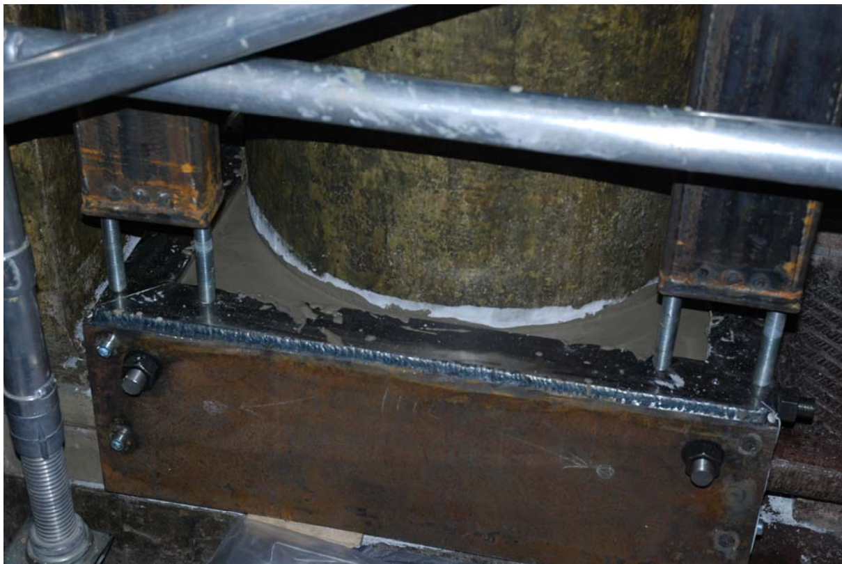
Krage fylld med expanderande betong.
