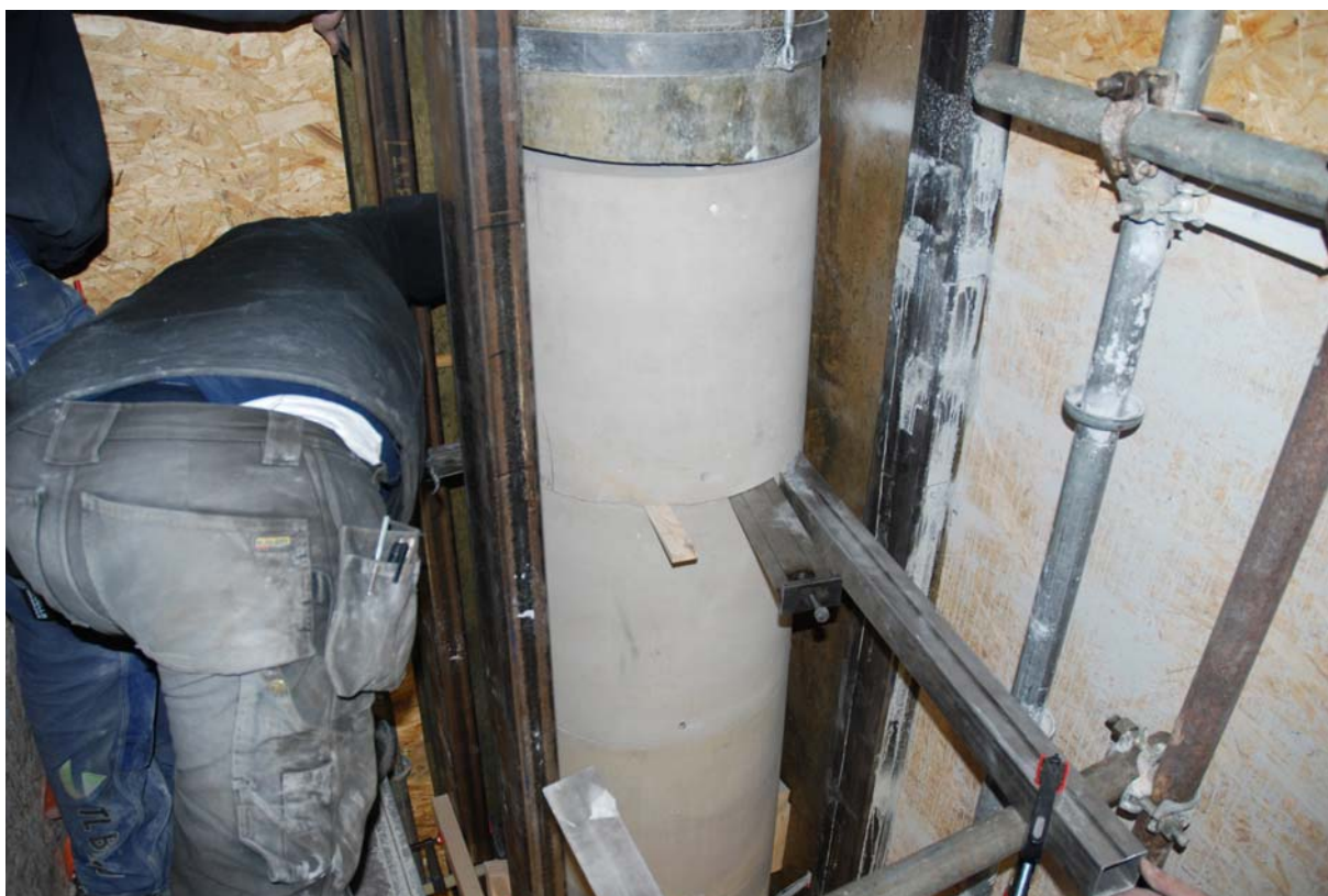
Skenor ersätts med blyshims med hjälp av de två tunna lyftverktygen.
