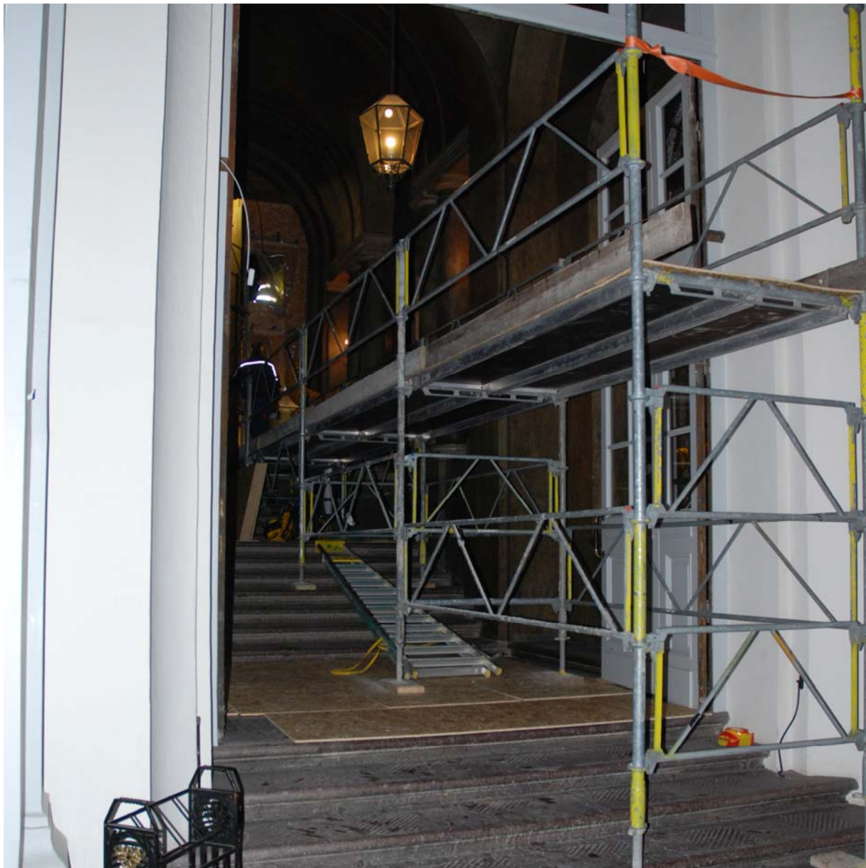
Horisontell ramp för ut- och intransport av sten.
