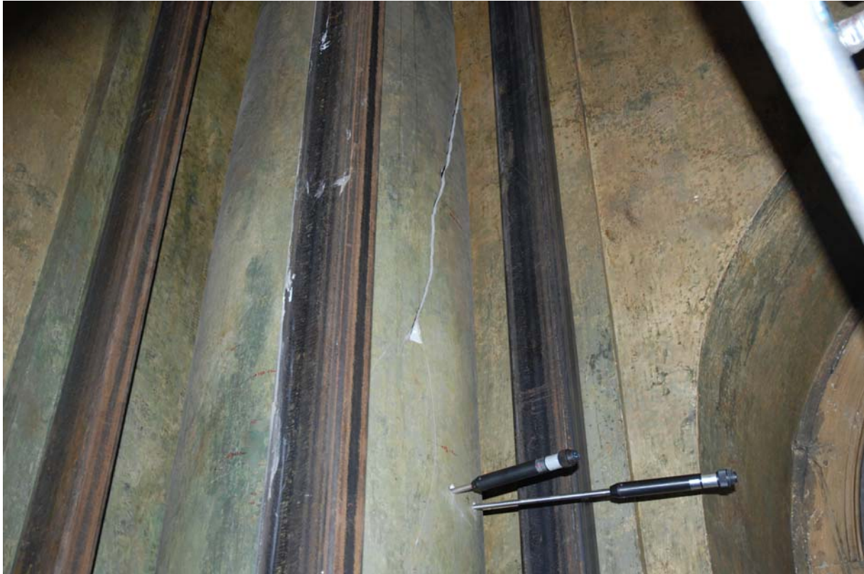
Givare för fuktmätning inuti kolonnen.
