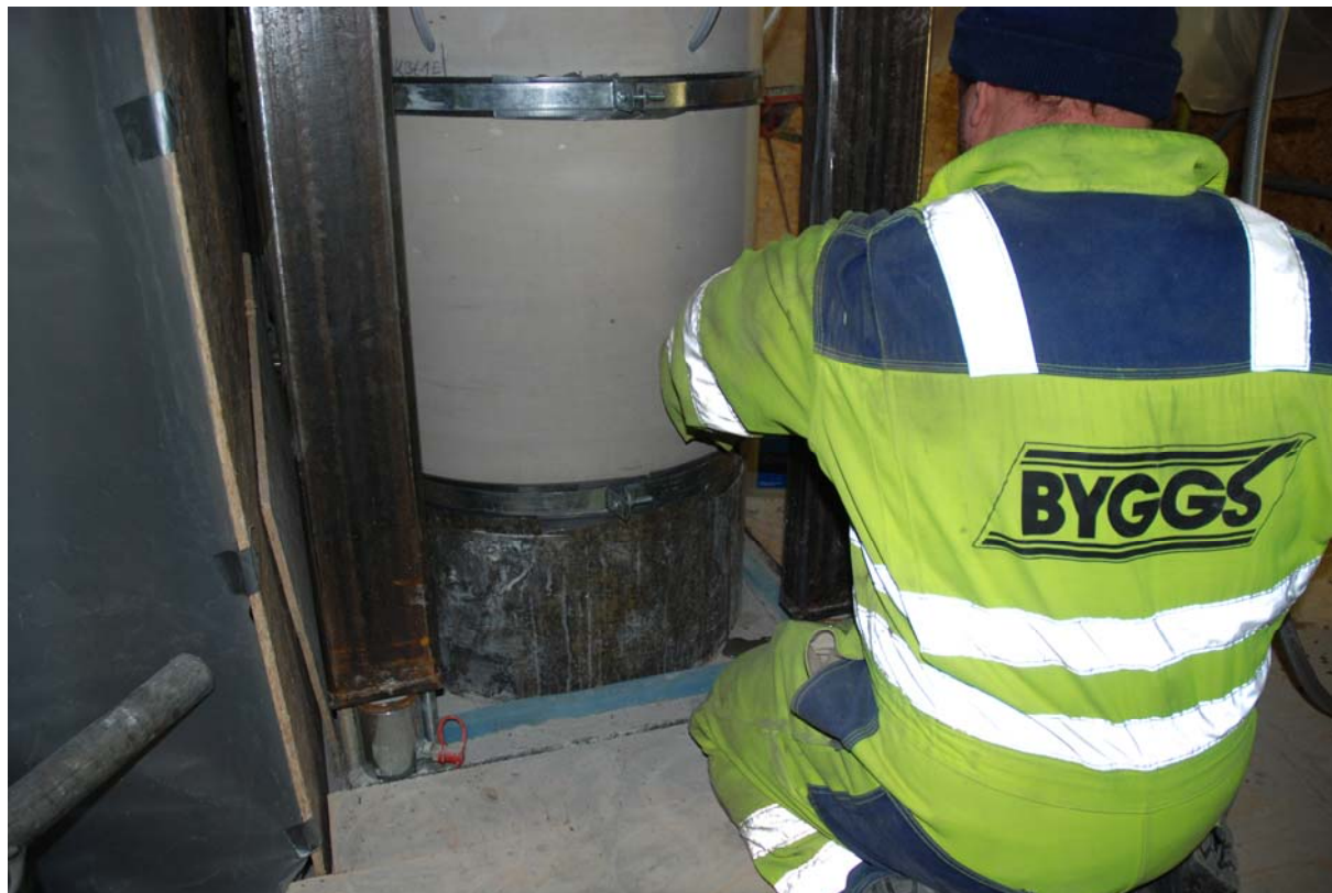
Injektering av nedre fog.
