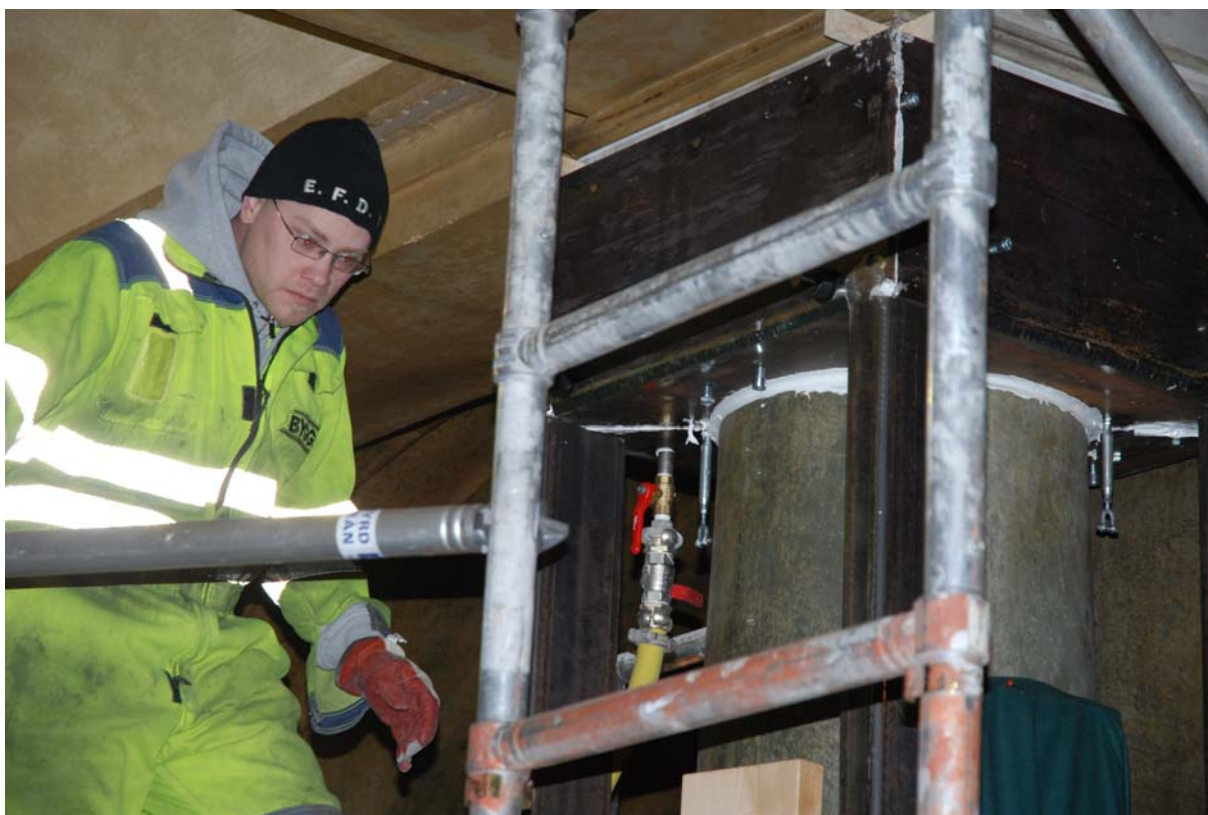
Inpumpning av betong i övre krage.
