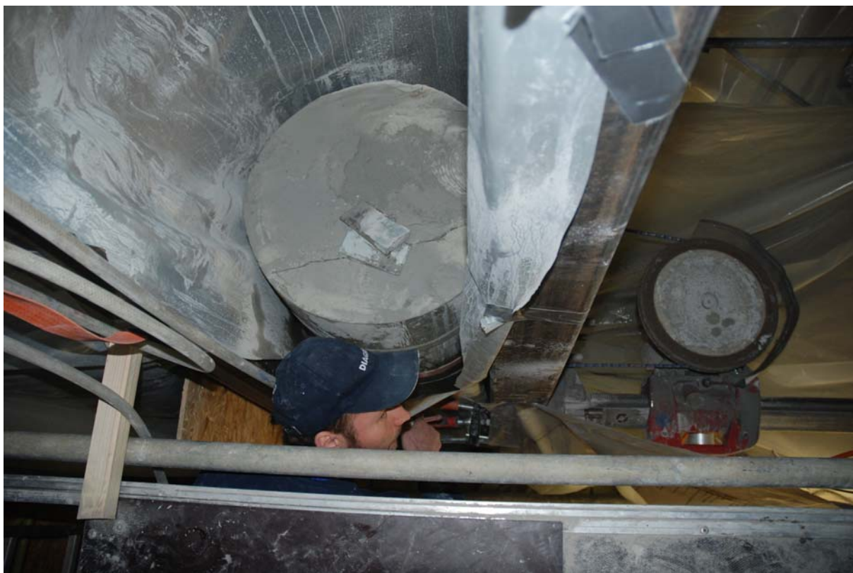
Vajersågning kolonn 3. Drivhjul syns till höger.
