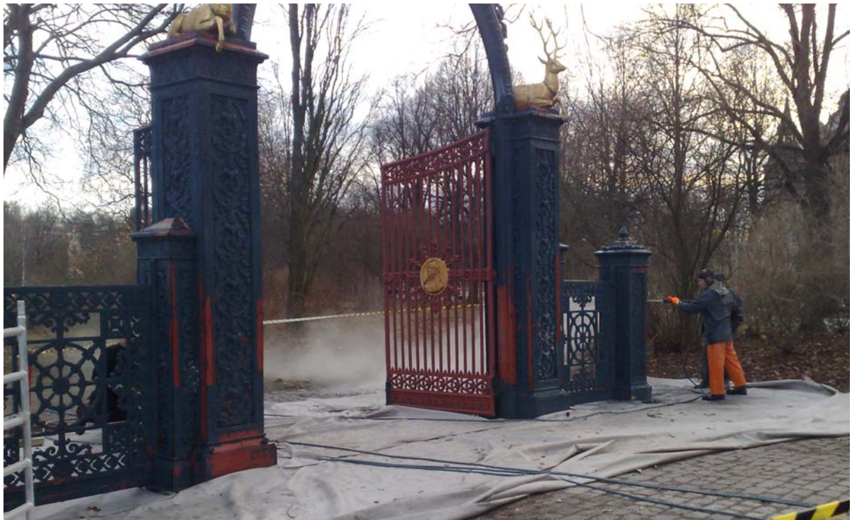
Högtryckstvättning med hetvatten för att få bort smuts, alger och plastfärg.
