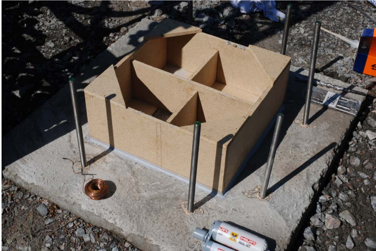
Plint och innerform. Innerformen kvarlämnas att ruttna bort av sig själv.
