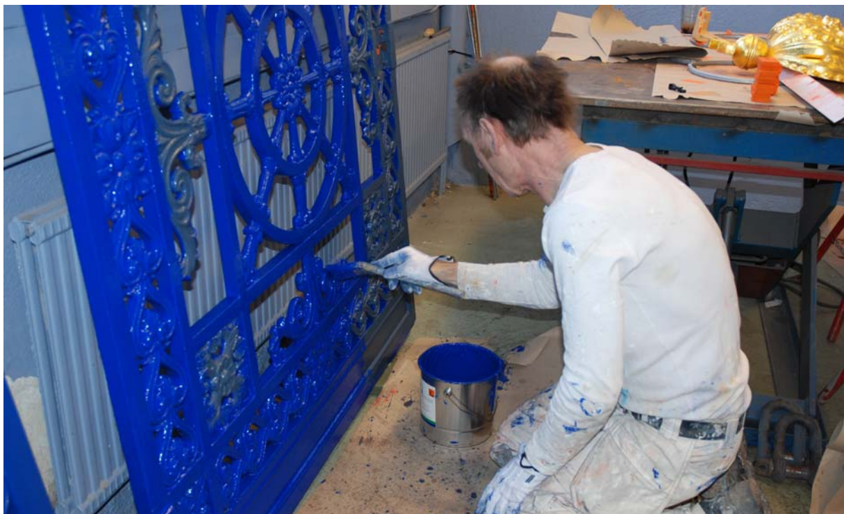
Målning av grindblad med koboltblå slutstrykningsfärg.
