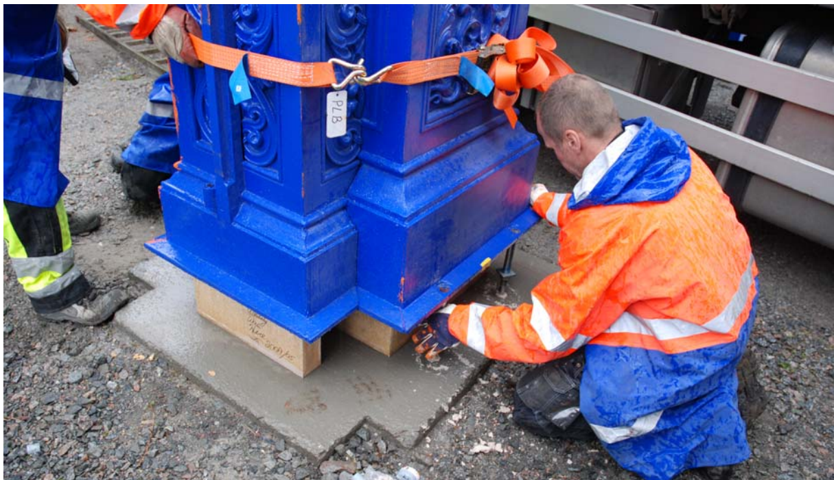
Montering av stolpe på grundbultarna.
