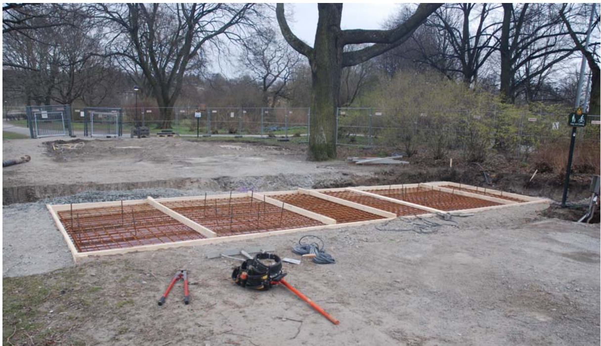
Klart för gjutning av betongplattan till det nya fundamentet.
