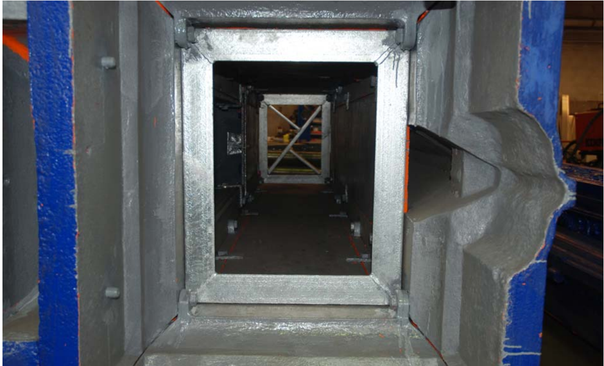
Nya uppstyvande förzinkade stålramar i en stolpe.
