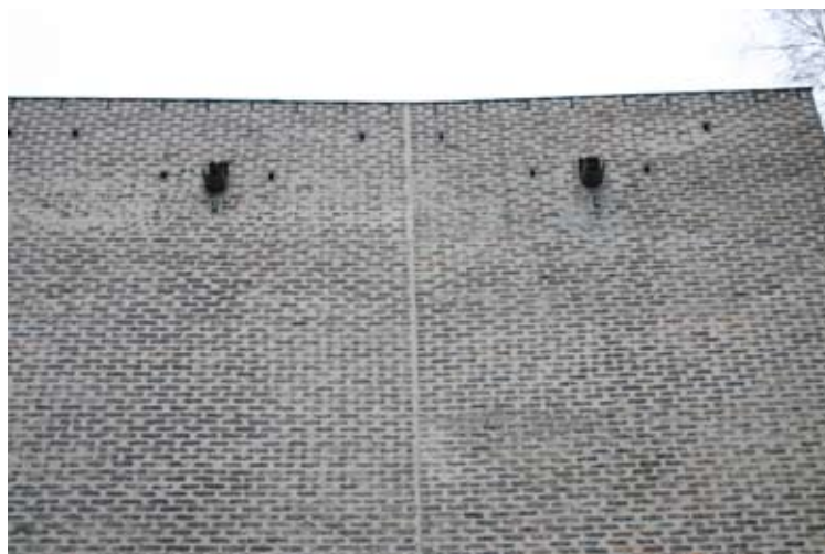
Murkrön med vattenutkastare
