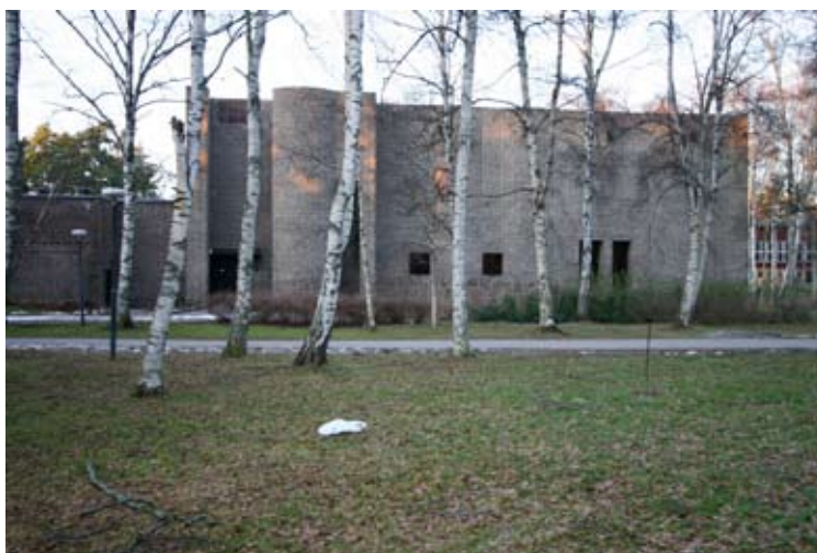
Markuskyrkans fasad mot söder, sett genom björkarnas gallerverk.
