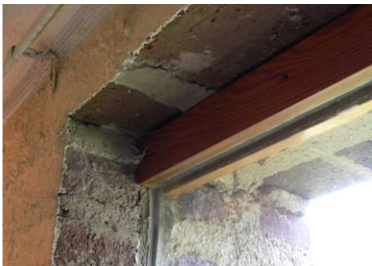
Infästning av glas i mur. Partiets övre del, insida.
