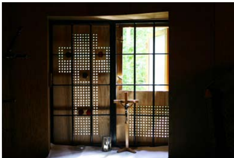
Sakristians fönster med ljusinsläpp genom fänérskivorna. Innanför har ett stålgaller monterats.
