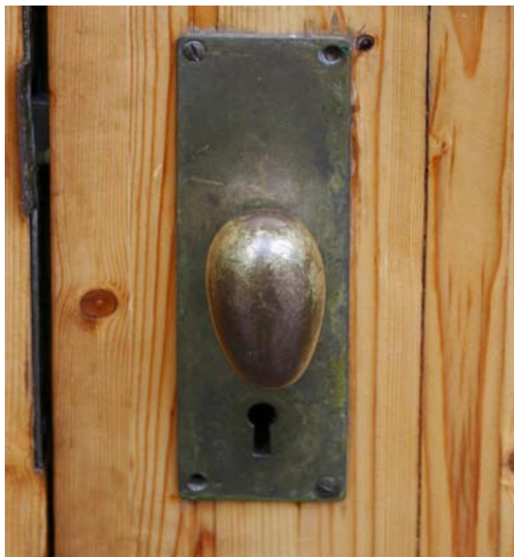
Äggformat trycke på ytterdörr. Borttaget och ersatt med nödutrymningsbeslag.
