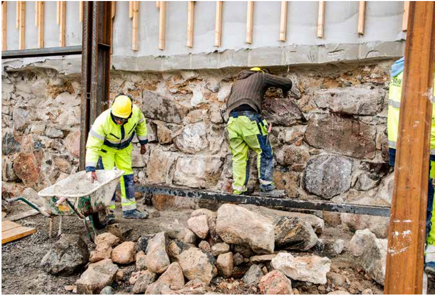
Återuppmurning sten mot sten pågår i nedre etappen. Omgivande befintliga murar användes som förebild för utseendet.
