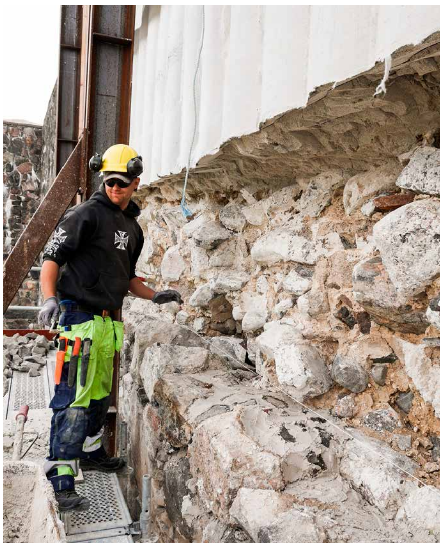
Uppbyggnad under det skyddande skiktet av EPS-cement. I höjd med hantverkarens hand syns ett upphugget hål för bindare.
