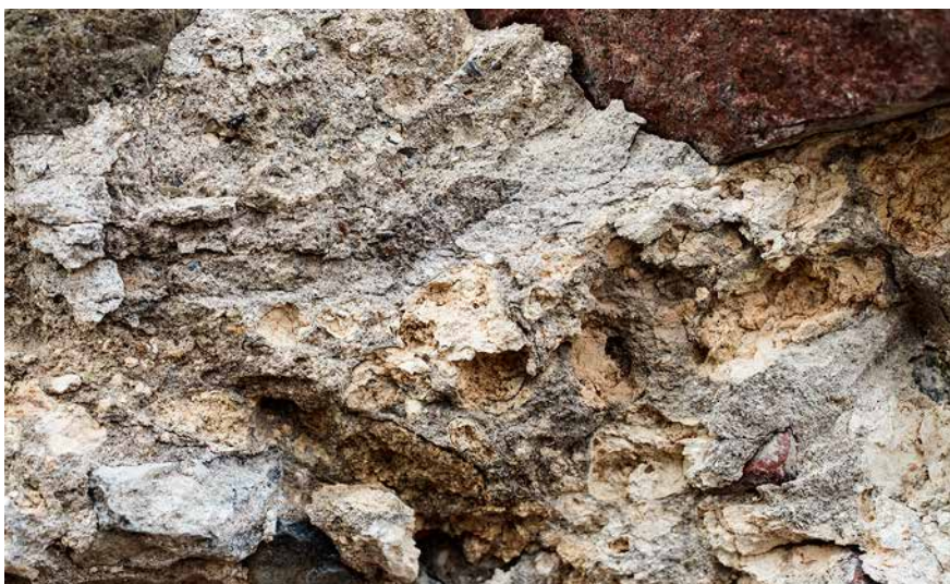
Nederst i bild: dåligt blandat bruk med kalkklumpar. Högre upp: välblandat bruk.
