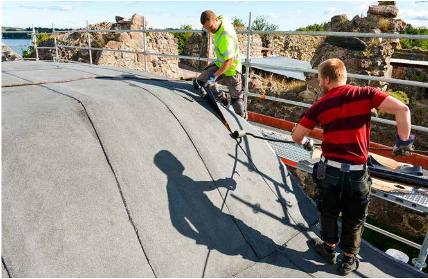
Läggning av asfaltmatta.
