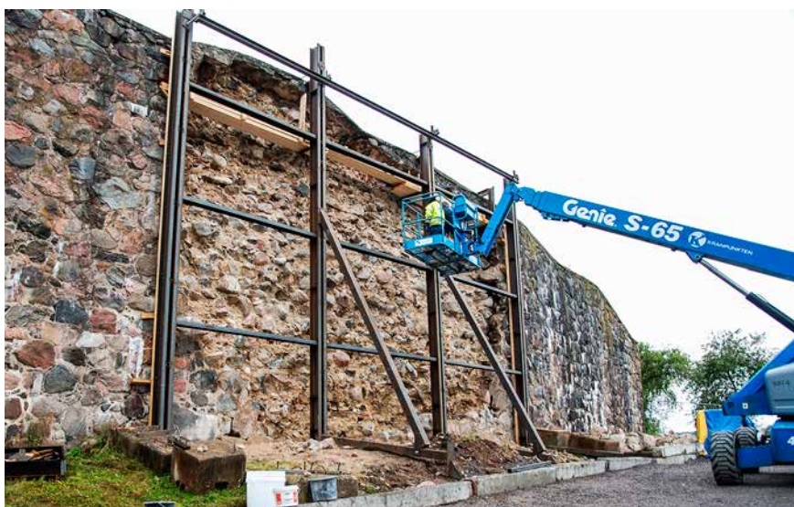
Stålkonstruktionen kompletterad. Rensning av kärnan utfördes från bomlift.
