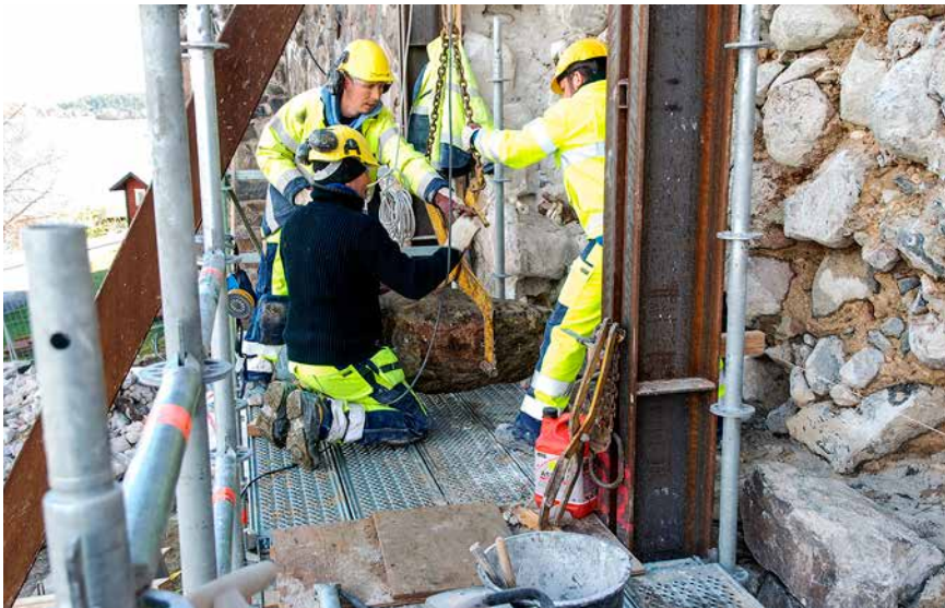
Bindsten baxas på plats med hjälp av stensax.
