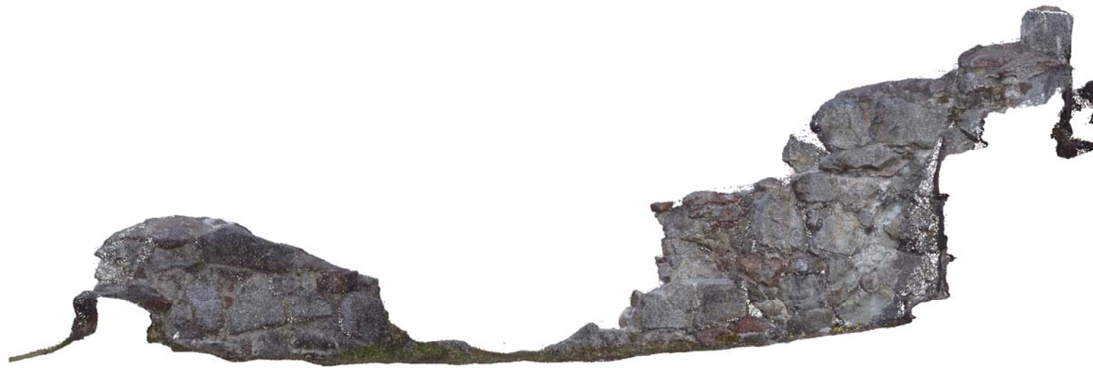
1 Källarkorridor C mot norr 1 : 20
