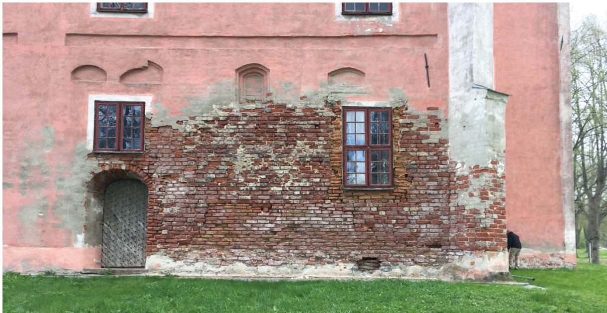
Utseende före åtgärd.
