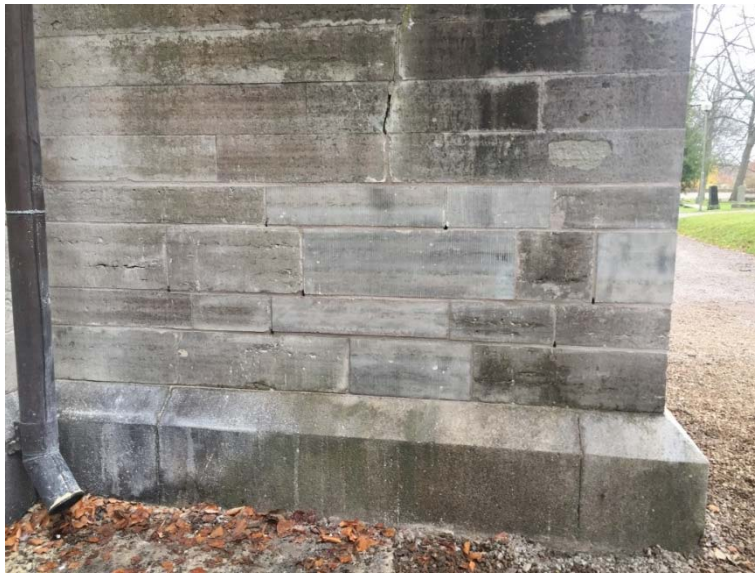
Nya stenar med liggande klov har monterats (2018).
