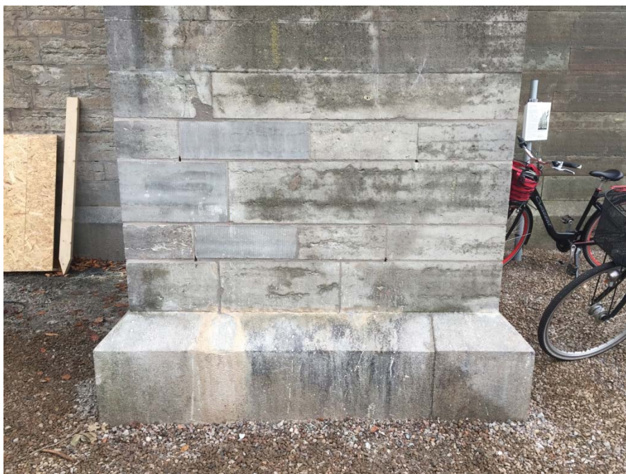
Sydsidan av strävpelare S1 med nya stenar och dräneringshål (2018).
