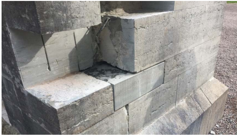
Spräckta stenar borttagna, en ny sten monterad och fogar injekterade (2018).
