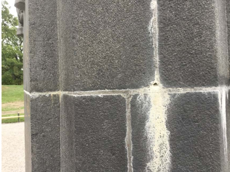
Vega-monumentet med kapillärbruten fog.
