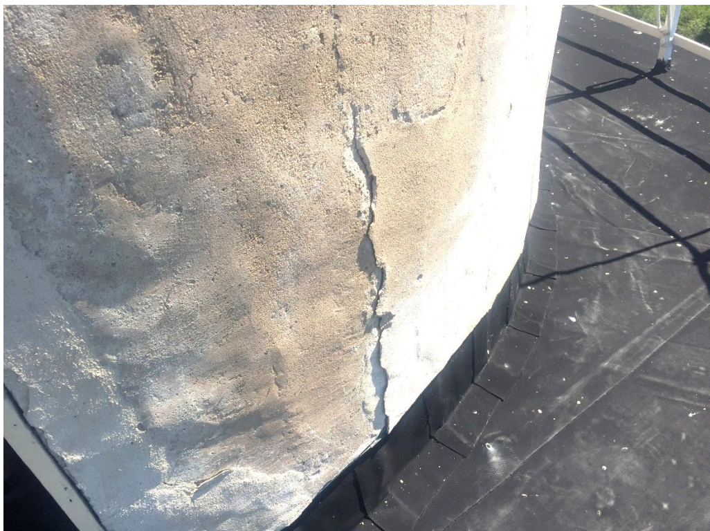
Putsen på rundeln har spruckit och släppt. På ett mindre parti höger om dörren.
