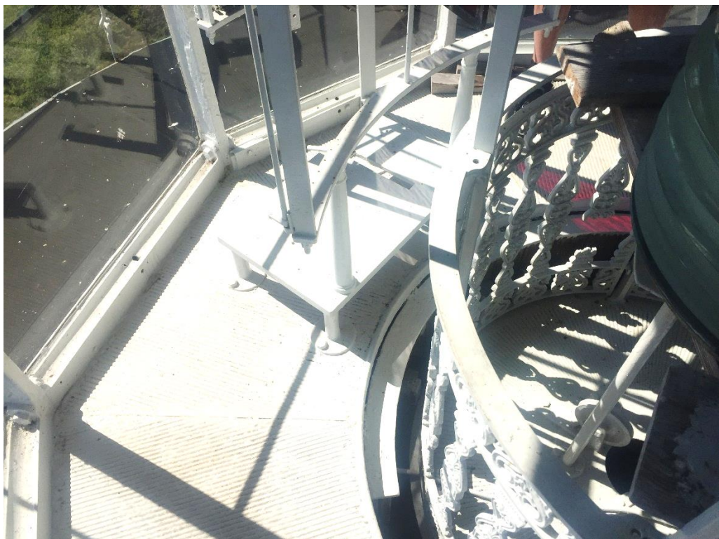
Även hålen i undre rännan kan behöva rensas.
